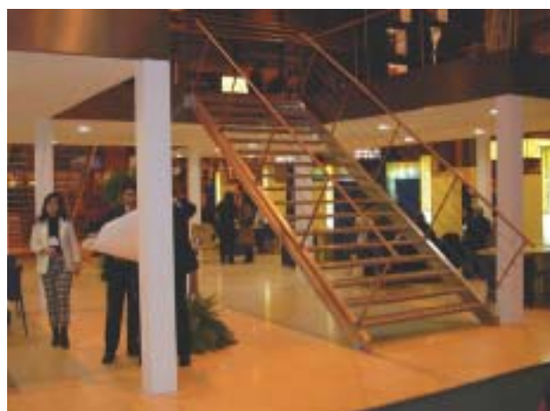
Ejemplo de mala práctica de pabellón con área expositiva en segunda planta sin ruta alternativa accesible
