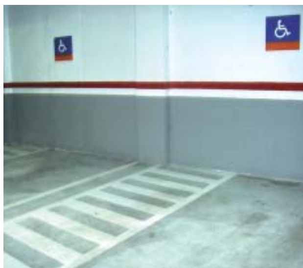
Buena práctica de plazas de aparcamiento reservado para personas de movilidad reducida
