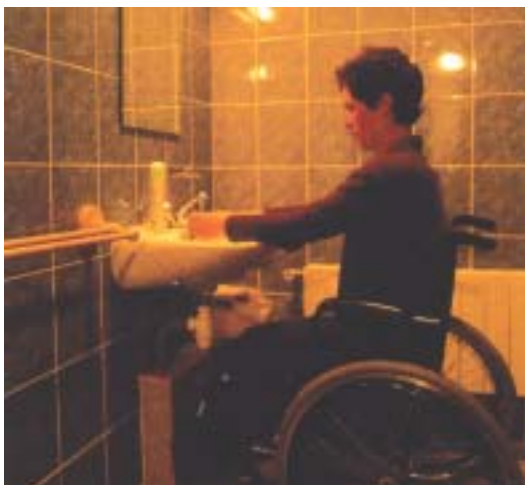
Lavabo que permite la aproximación frontal de una persona en silla de ruedas.
