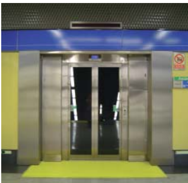
Ejemplo de señalización de ascensor con pavimento de textura y color diferenciado
