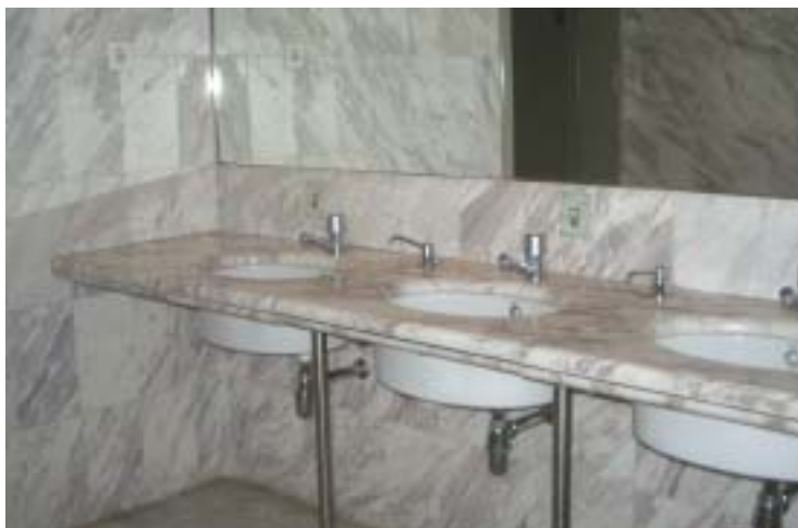
Lavabos que permiten la aproximación frontal de una persona en silla de ruedas.
